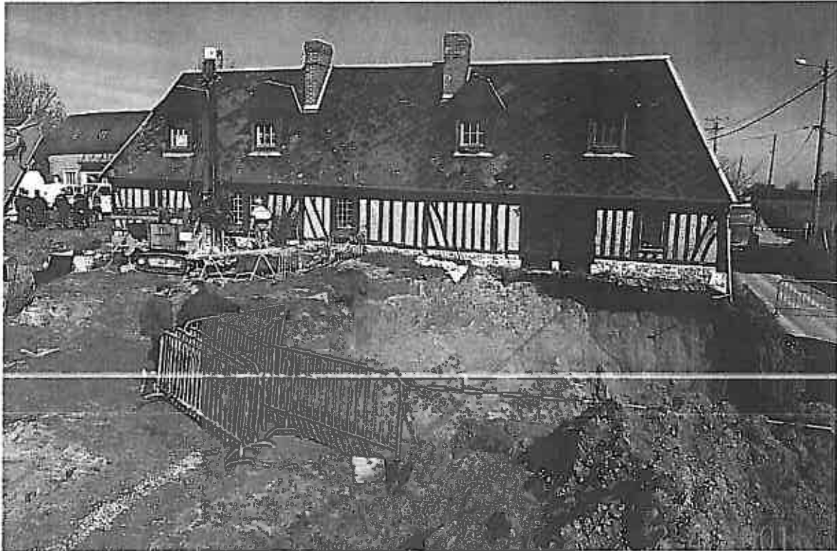
Accident dû à la rupture d'une marnière dans l'Eure
