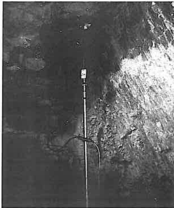
Inspection de cavités à Colomars
